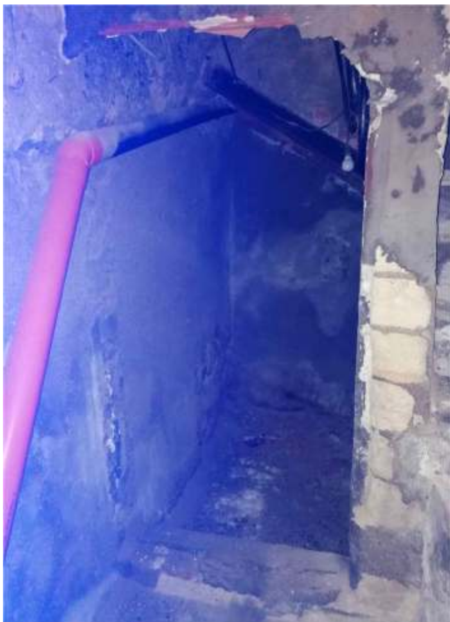
Foto 9 (P.S1 – Loc. di sgombero)
