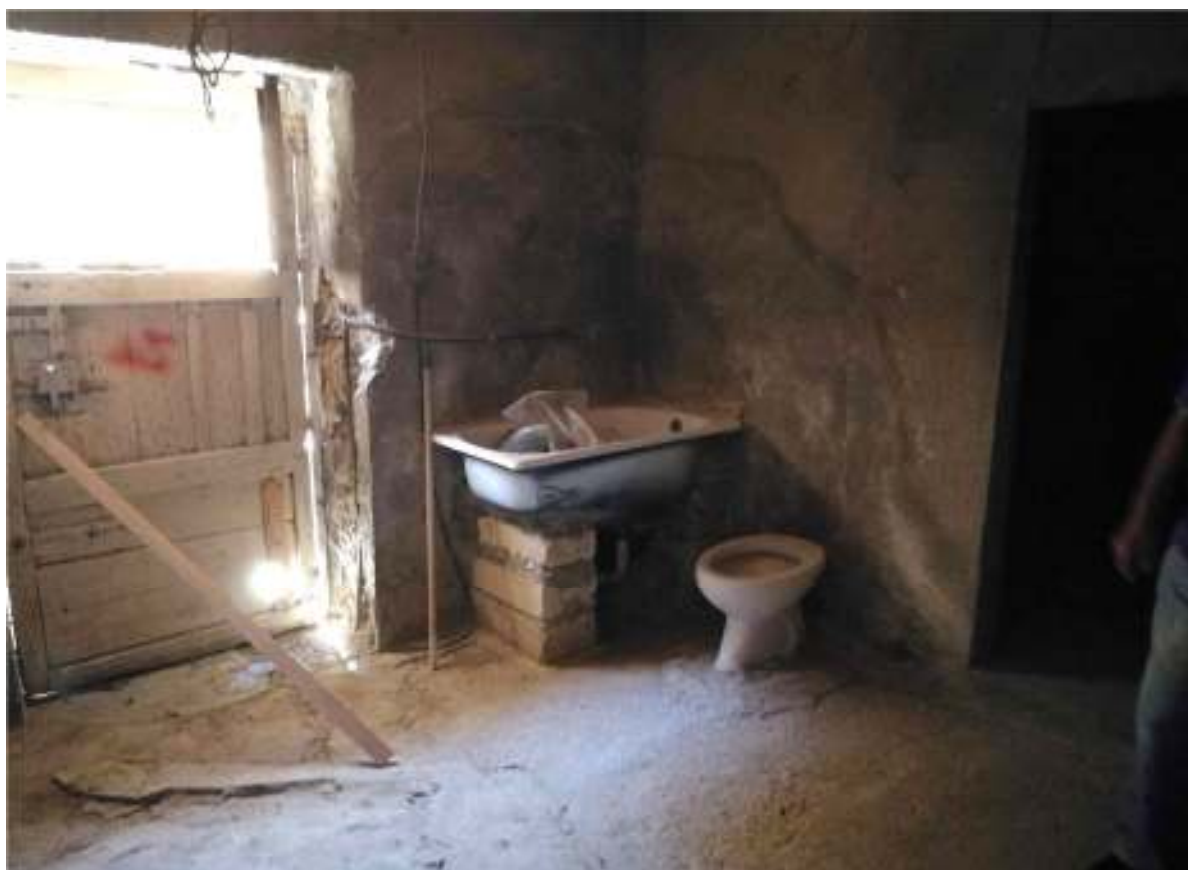
Foto 8 (P.S1 – Loc. di sgombero)
